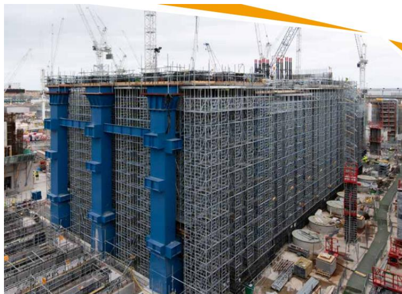
Turbine Hall base slab concrete pour
